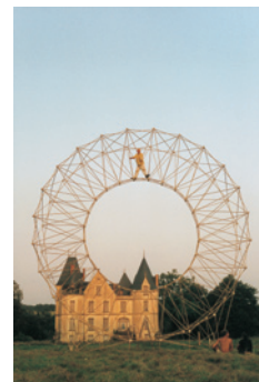
Construction en bambou d'Antoon Versteegde au Domaine de Boisbuchet en 2000
